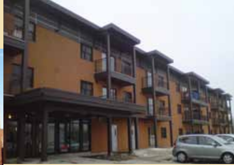
Chantier Coopérative Le Bourg Saint-Antoine, Saint-Jérôme
