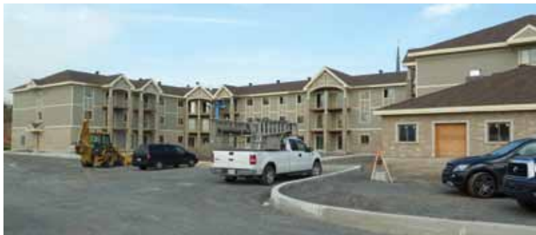
Chantier Manoir Blainville
