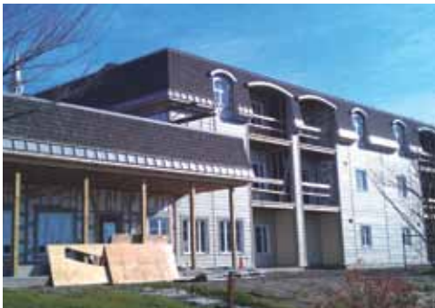
Chantier Corporation des Aînés de Saint-Léon-de-Standon
