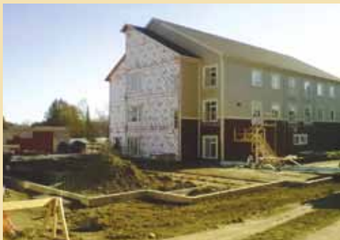
Chantier Les Habitations Dégelis
