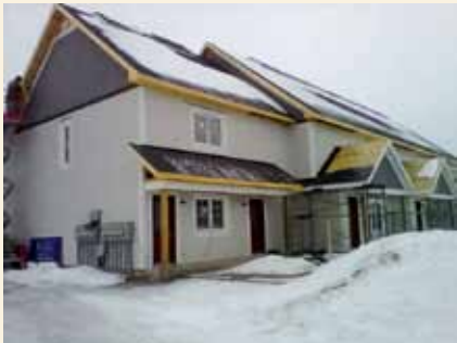
Chantier Les Habitations Populaires de l'Isle-Verte
