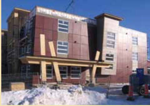
Chantier Résidence Gérard-Blanchet, Desbiens
