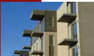
Photos ci-dessus : Chantier Coopérative de l'ARC
