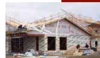
Chantier L'Arche d'Amos
