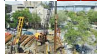
Chantier C. H. Radar, Montréal
