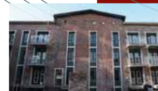
Chantier Coopérative Station #1, Montréal
