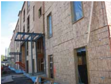
Chantier des Ateliers municipaux
